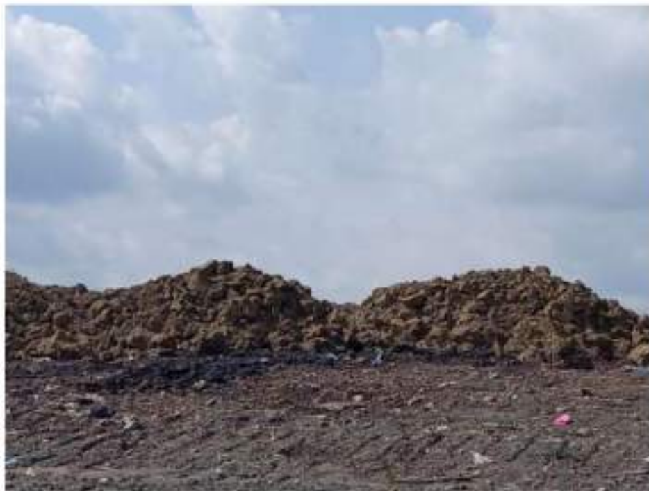
Фото 2.18 Підготовка для додаткового перекривання схилу полігону ТПВ
