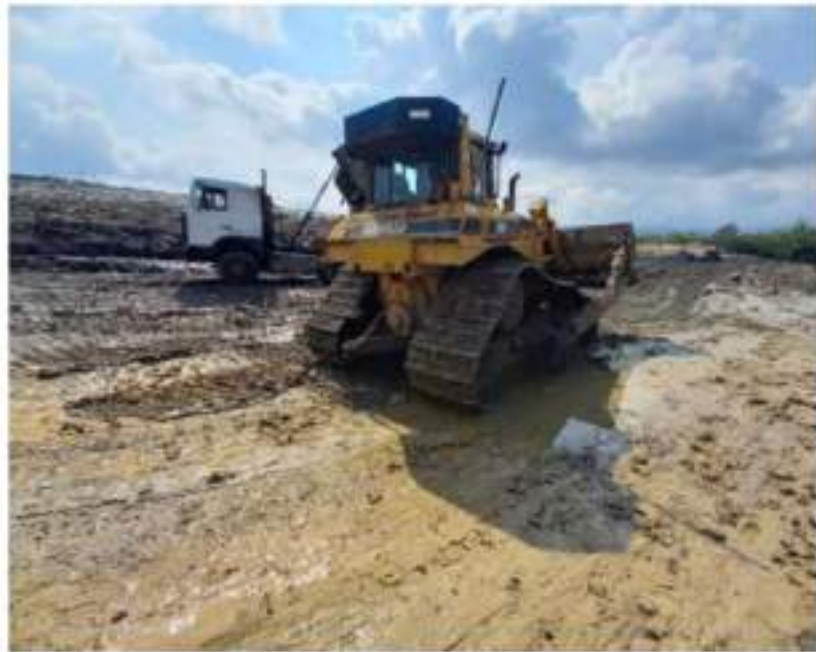
Фото 2.7 – 2.8 Вивантаження та утрамбування відходів
